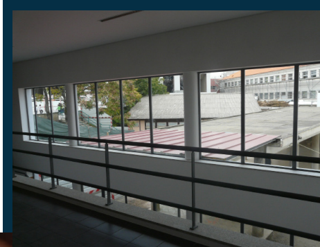
Pormenores do bloco que se encontra concluído no lado sul
